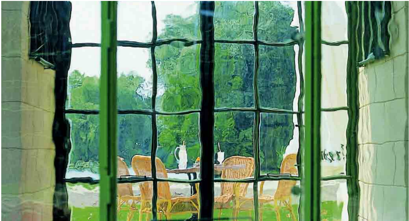
Orangerie im Schloss Schwerin: Mit RESTOVER® blieb der historische Charakter der Fenster erhalten.
